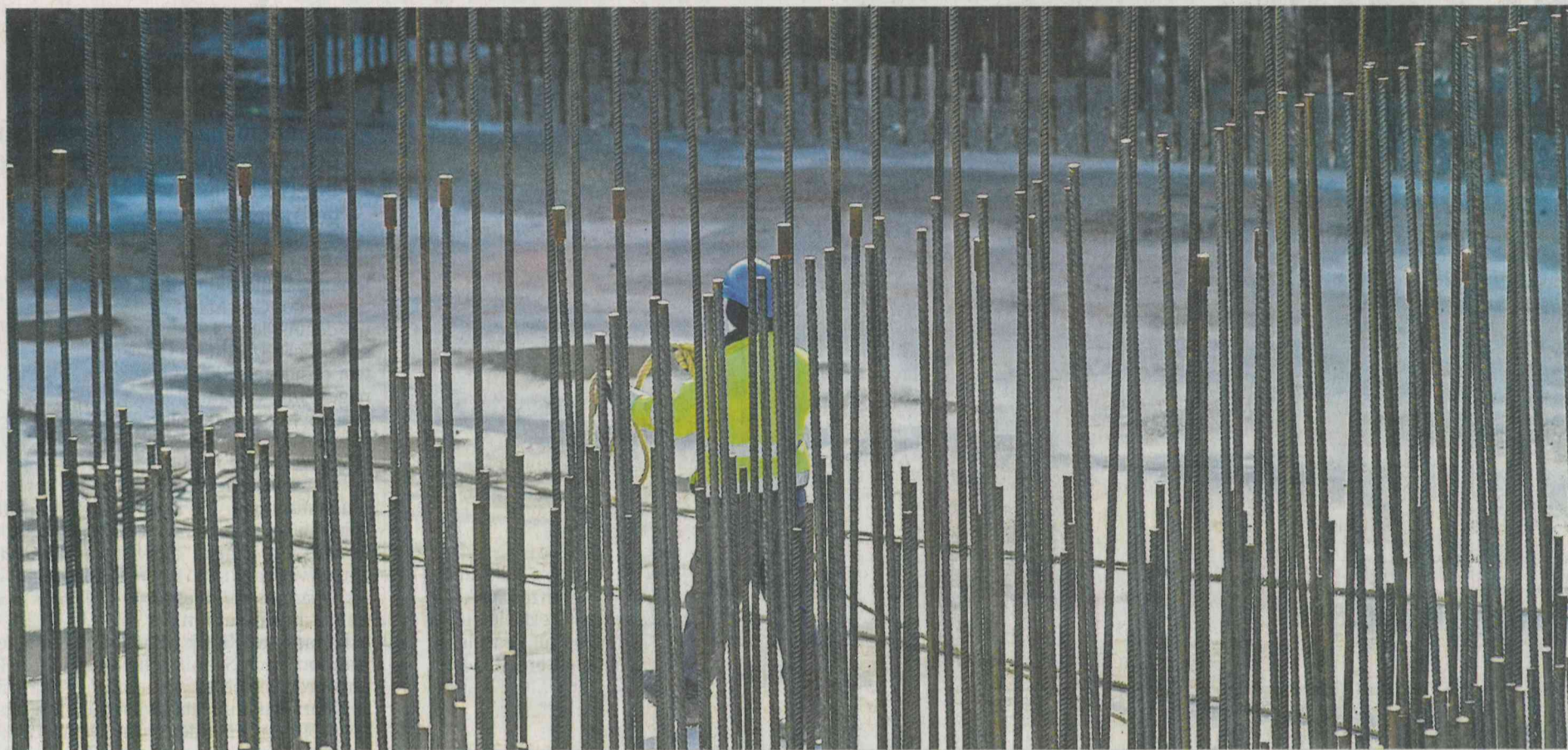
Ein Arbeiter geht über eine Großbaustelle. Auch die Baubranche leidet unter Corona-Maßnahmen.
